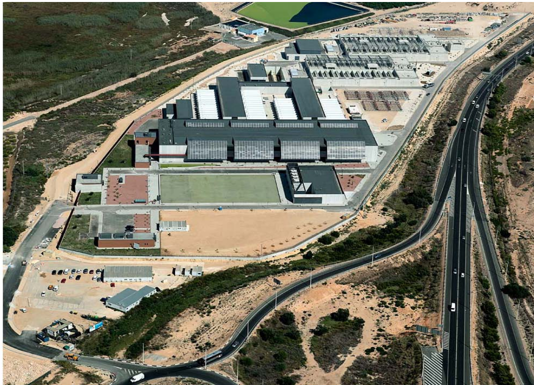
Desaladora en construcción de Torrevieja en Alicante, para abastecimiento y uso agrícola, promovida por el Ministerio de Medio Ambiente.
