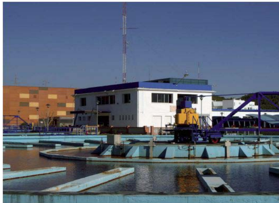
Desalobradora de El Atabal, para abastecimiento de la ciudad de Málaga, promovida por el Ministerio de Medio Ambiente.
