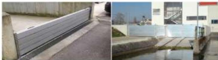
Figura 40. Puertas de cierre estancas modulares que ofrecen solución de continuidad al muro de cierre, montadas dentro de dos perfiles en U ancladas en una pared. Es posible instalar postes intermedios en áreas más grandes. Fuente (a2): Aggüres. Dcha.: Rjet.
