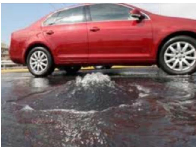
*Figura 7 El deterioro o robo de las tapas de los pozos de registro puede generar importantes problemas en el sistema por la entrada de aguas de lluvia y la introducción de piedras y basura (por arrastre lluvias o intencionadamente). Fuente: Masaya 2013*
