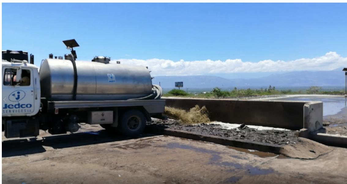
*Figura 8 Descarga de camión de excretas en la planta de tratamiento de Morne a Cabrit, Haití.*
