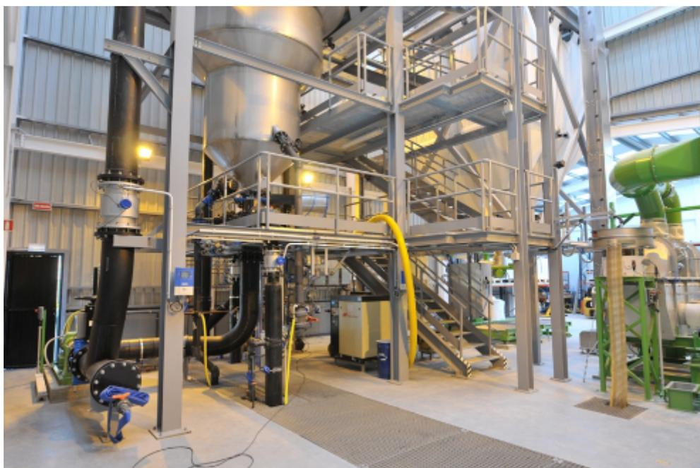
*Figura 4 Planta de producción de estruvita a partir de los retornos de la línea de lodos de la Estación Depuradora de Aguas Residuales Sur de Madrid, España. En funcionamiento desde 2016, está diseñada para una producción de 260 kg de fósforo al día.*
