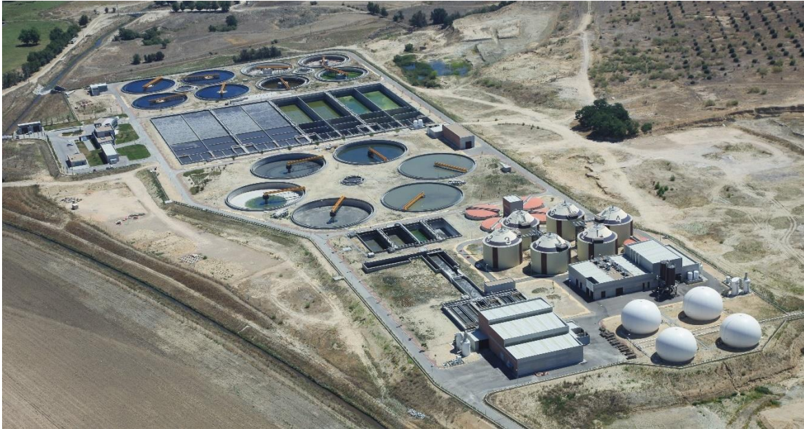
Figura 4. PTAR de Arroyo Culebro Cuenca Baja. Fuente: Canal de Isabel II
