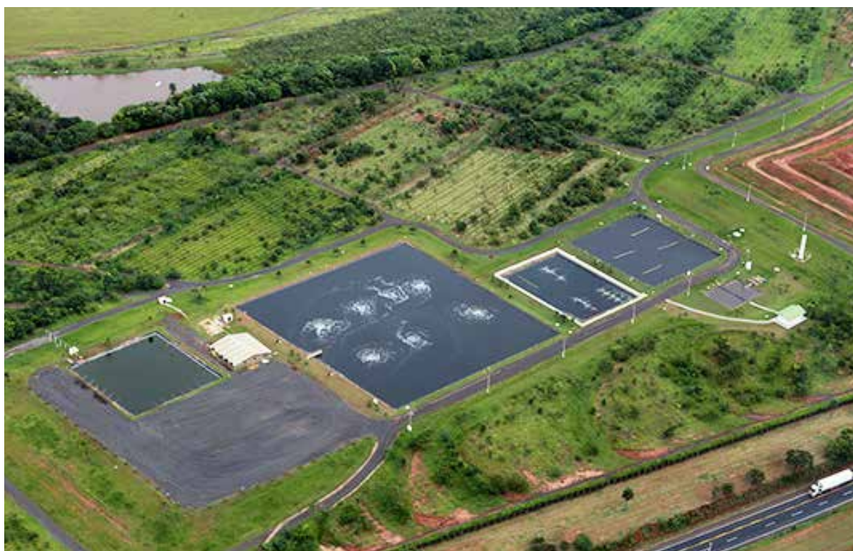
Estação de tratamento de água (ETA). Bacia do Rio Grande (Brasil)
