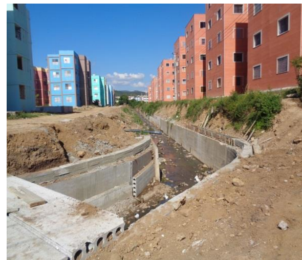
Drenaje Quibará, Stgo de Cuba.
