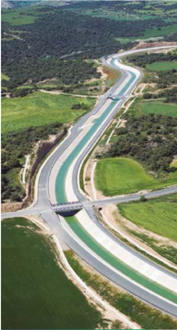
Segarra- Garrigues Canal (Lleida, Spain)
