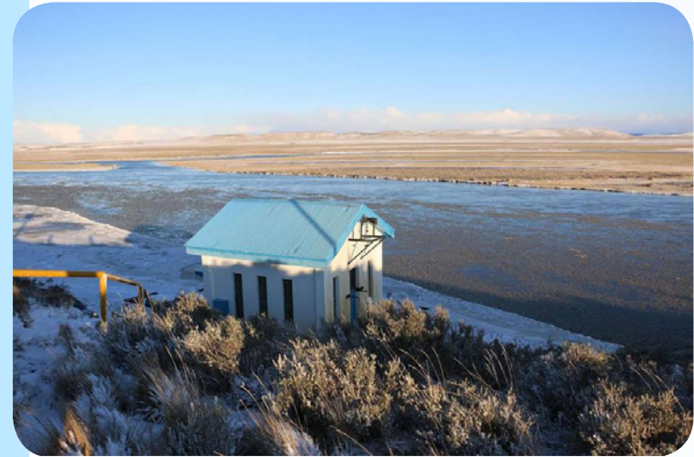
Figura 7. Casilla de bombeo del río Grande. Obras Sanitarias Municipal.
