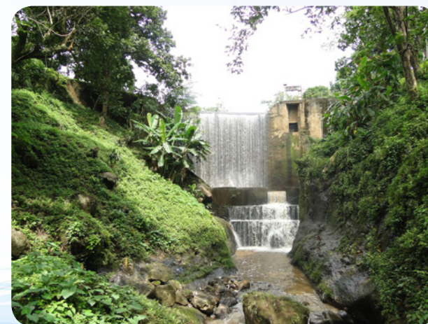
Figura 4. Hidroeléctrica Sensunapán 2.8MW
