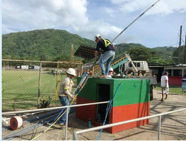
Figura 15. Instalación SIMASTIR. Monitoreo en pozo Estadio Chorotega: Acuífero Nicoya
