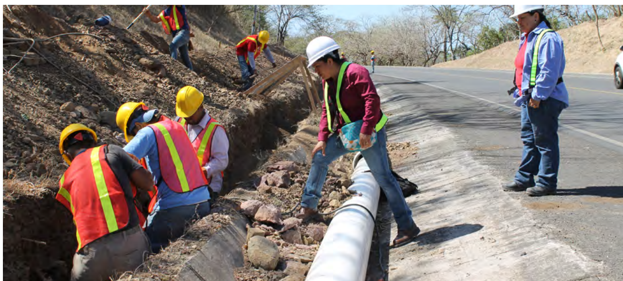
Construcción de canalización para agua potable en Acoyapa, Nicaragua
