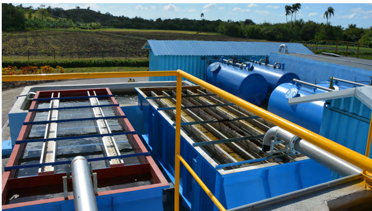
Acueducto en Báguanos, provincia de Holguín, en la zona norte oriental de la isla de Cuba
