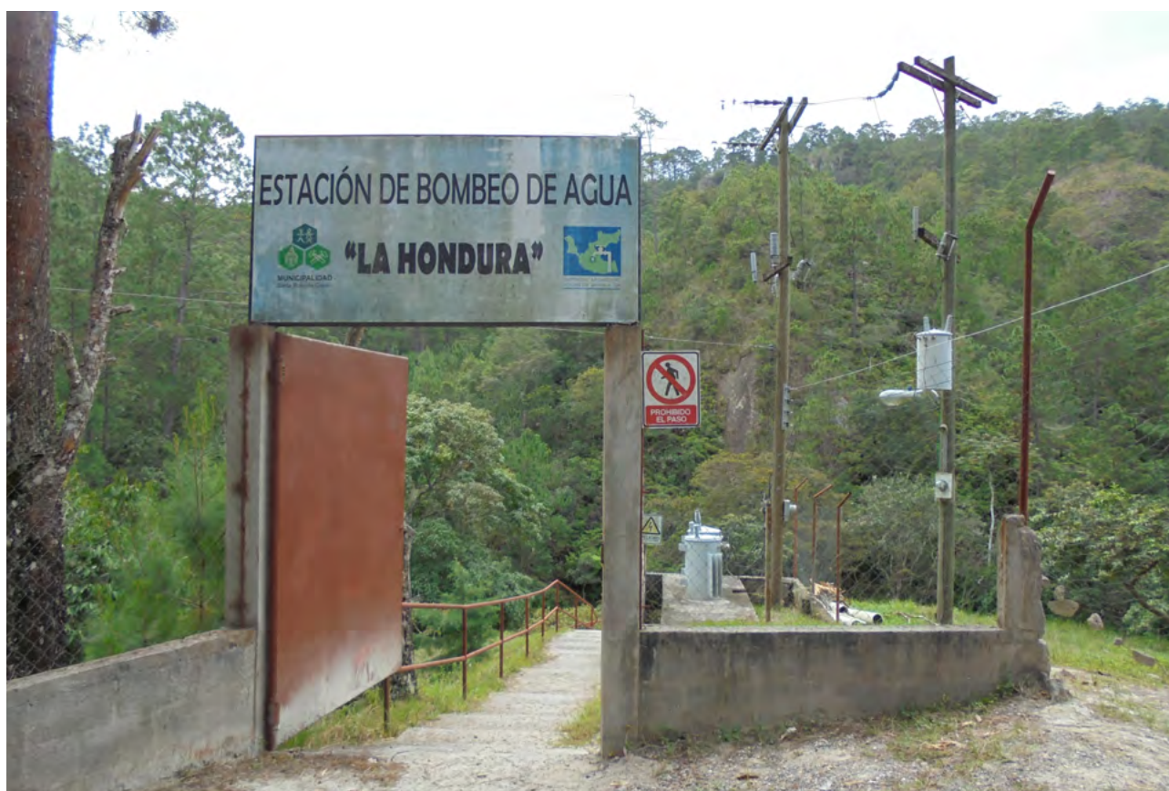
Estación de bombeo de agua en Honduras
