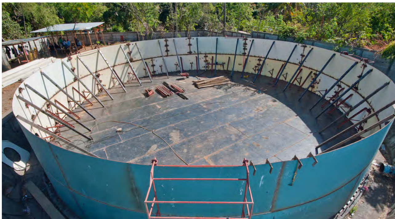
Construcción de depósito de agua potable en Masaya, Nicaragua
