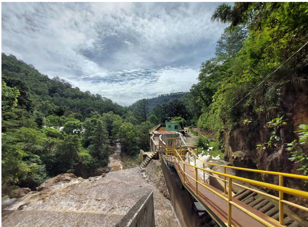
Abastecimiento de Ciudad de Guatemala. Acueducto Xayá-Pixcayá en Chimaltenango, Guatemala.
