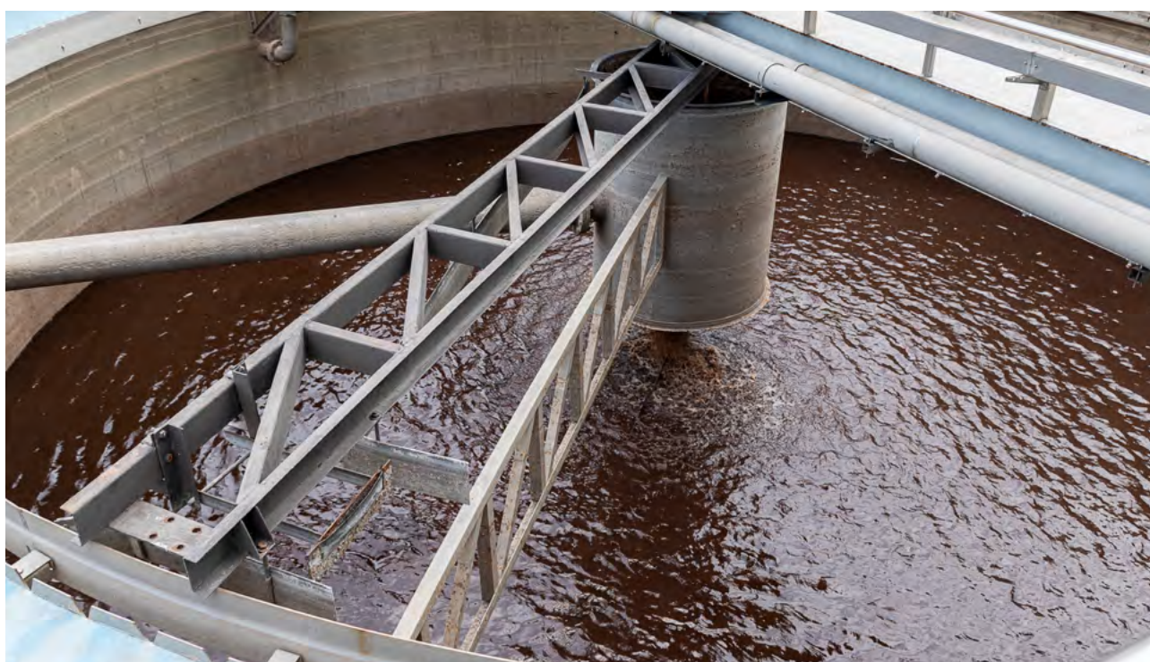
Estación depuradora de aguas residuales. Decantador por gravedad
