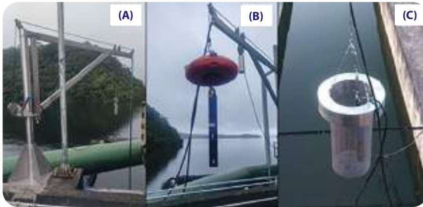
Figura 8.11. Soluciones para la instalación de la sonda multiparámetro en el cuerpo hídrico: (A) grúa metálica equipada con contrapeso con cable de acero; (B) dispositivo flotante acoplado a la grúa; (C) cesta metálica perforada.
