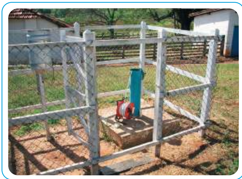
Figura 7.6. Pozo de monitoreo de agua subterránea.
