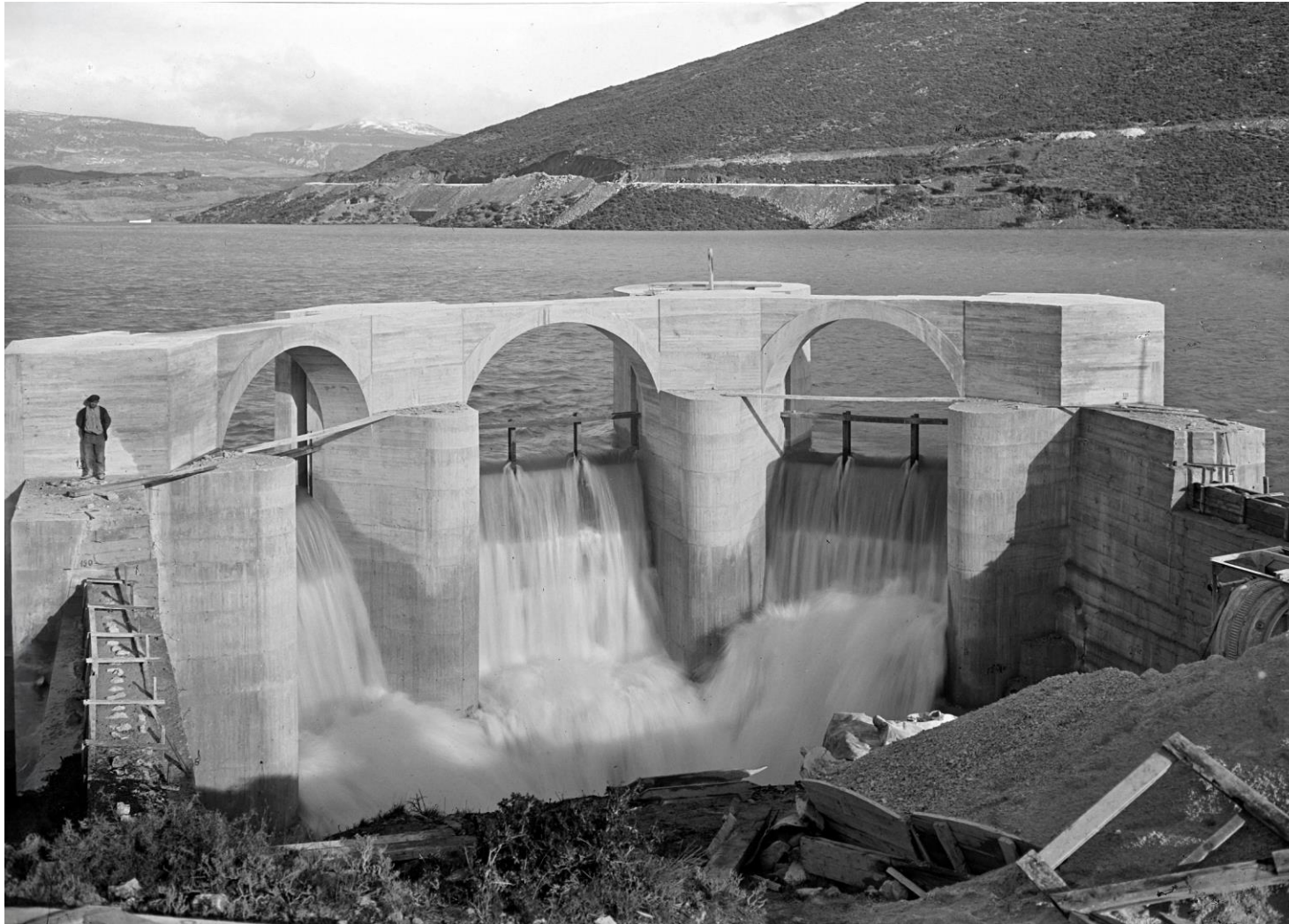
Aliviadero de la presa de Allos (Navarra), 1930
