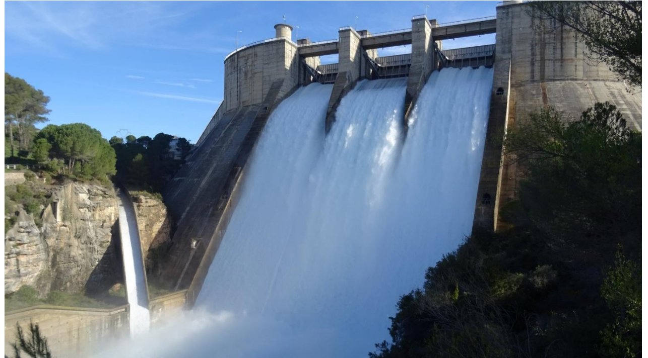
Presa del Grado
