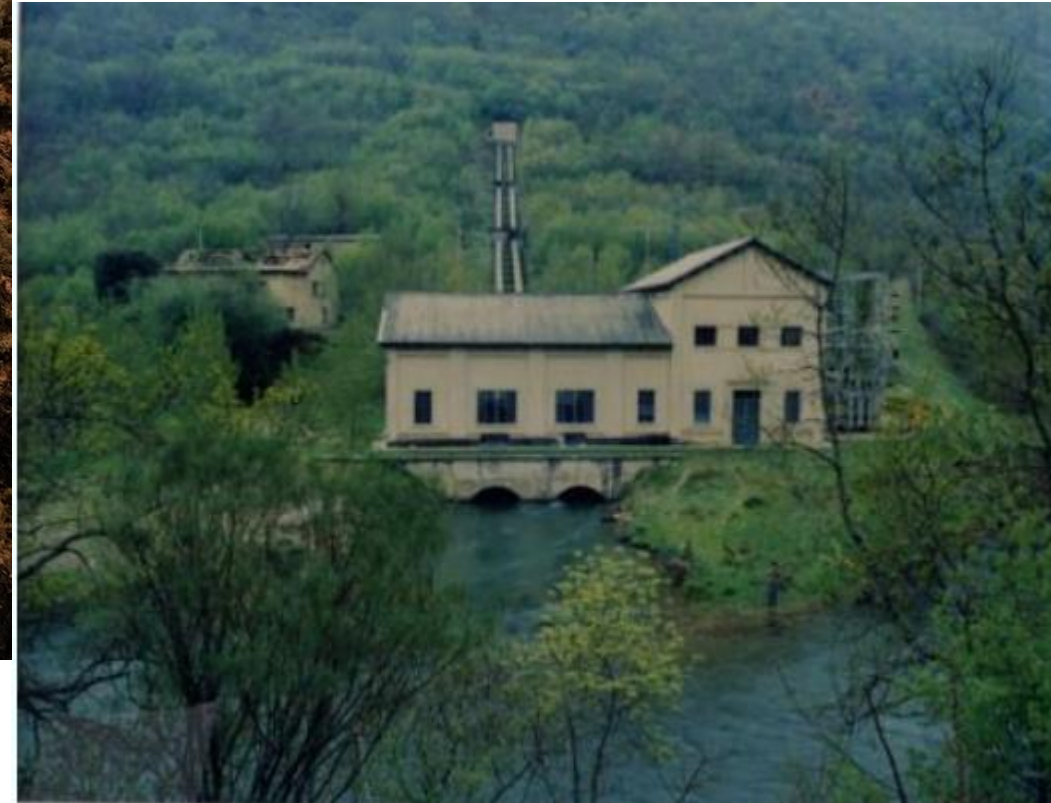
Edificio de la central
