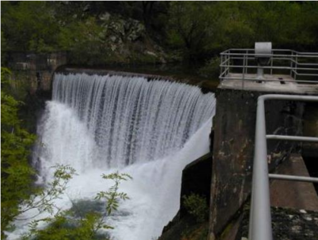
Presa de toma, río Najerilla
